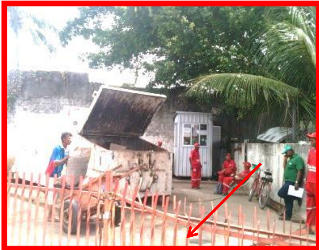
Compactador e cabine de apoio
