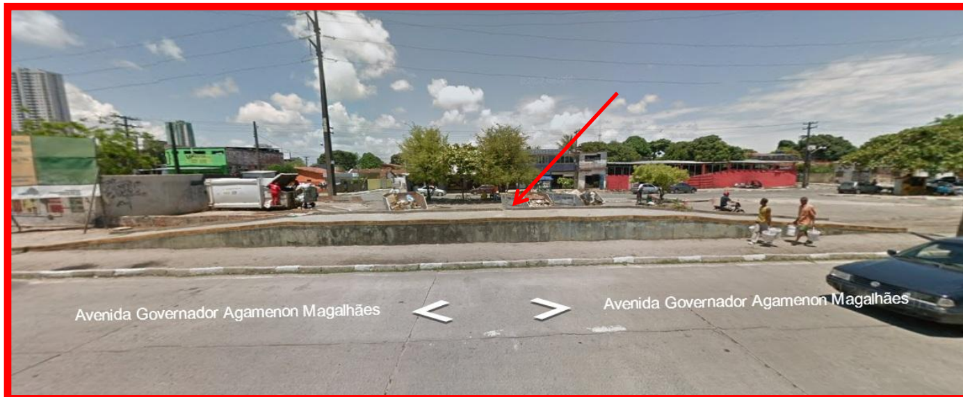
Rampa de acesso
